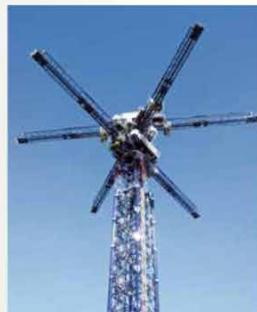
Ein Tessiner Start-up hat einen Turm entwickelt, an dem Kräne tonnen-schwere Betonblöcke mithilfe von erneuerbarer Energie in die Luft ziehen – und sie bei Bedarf wieder runterlassen: Dabei wird bis zu acht Stunden sauberer Strom für 2000 bis 3000 Wohnungen produziert.
